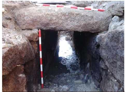
Alcantarilla de Manzanares el Real (Gómez 2010)
