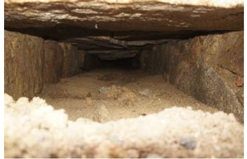
Alcantarilla en Plaza de la Iglesia nº 1
