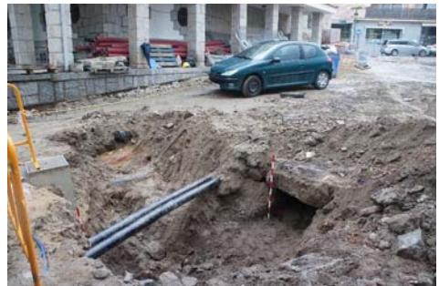
Tramo de la arqueta de telefonía
