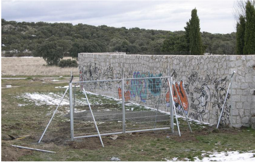
Instalación de la puerta de acceso (enero de 2005)
